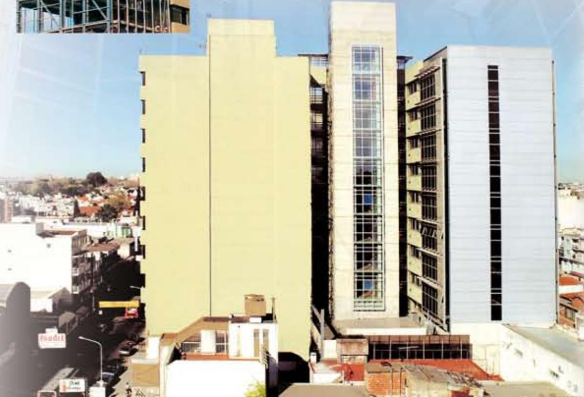
En Morón, Provincia de Buenos Aires, DIN S.A. construyó un edificio metálico de trece pisos para la nueva sede de la universidad.
