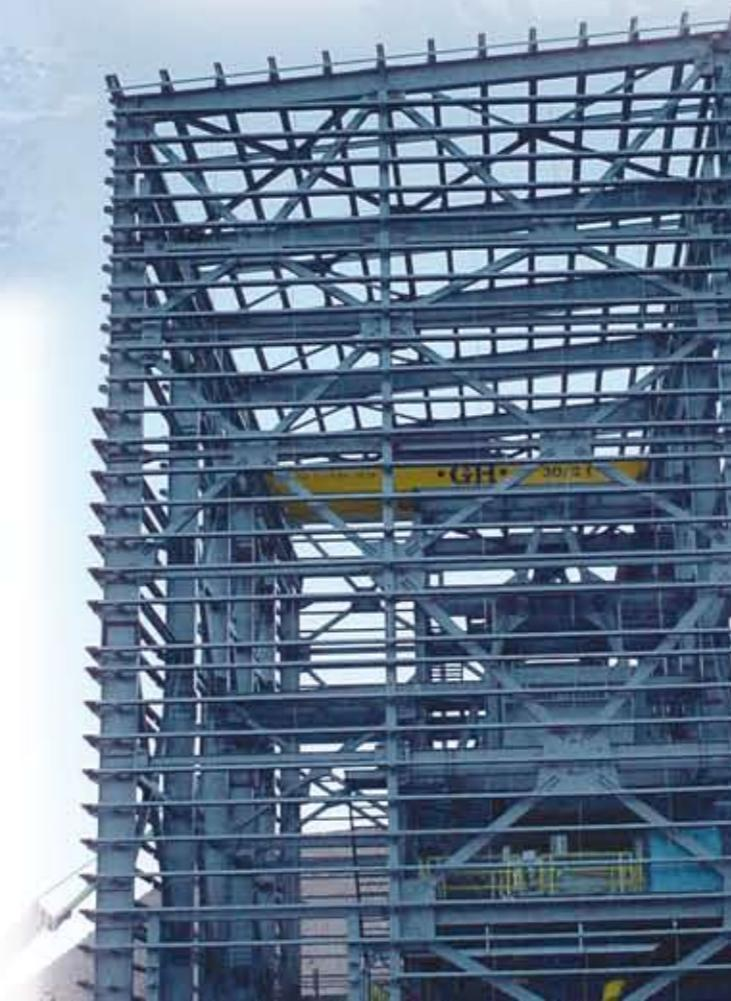
Desarrollo minero en la Provincia de San Juan a 4.600 m de altura s.n.m. compuesto de varios edificios como: Secondary Crusher, Truck Wash, Pregnant Solution, Electrical Room, Domme Platform, y otras, completando 850 Ton en 1.200 m<sup>2</sup>.
